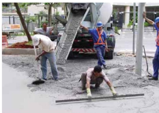
Figura 10 – Sarrafeamento do concreto
