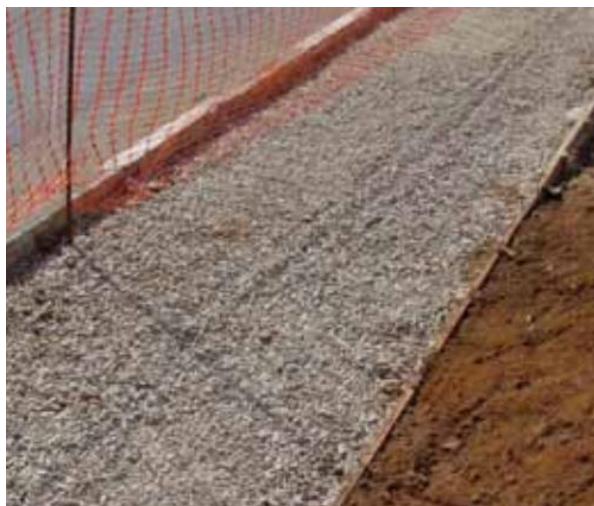
Figura 07 – Espalhamento da Camada de Brita
