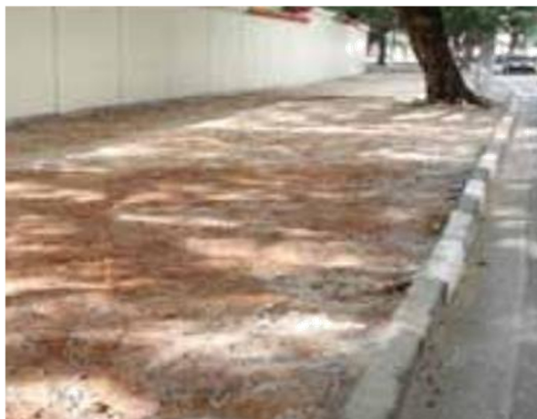
Figura 06 – Nivelamento e compactação do terreno
