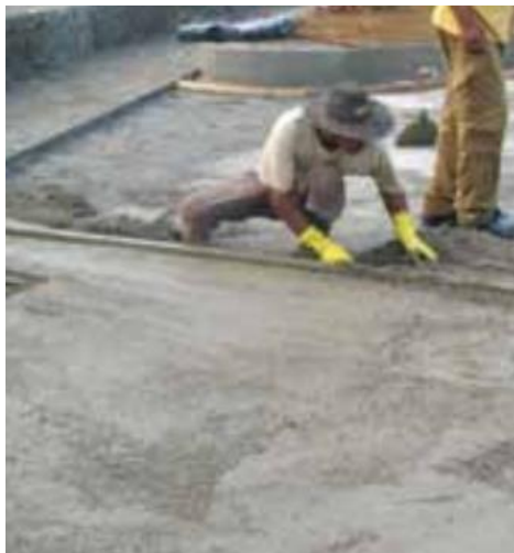
Figura 09 – Recebimento e espalhamento do concreto
