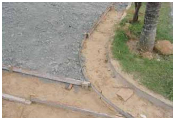
Figura 08 – Fixação das formas de madeiras
